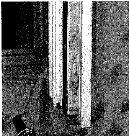
Bild 3: Weißkorrosion an Beschlagteilen (Foto: Fa. Menck, Hamburg)
